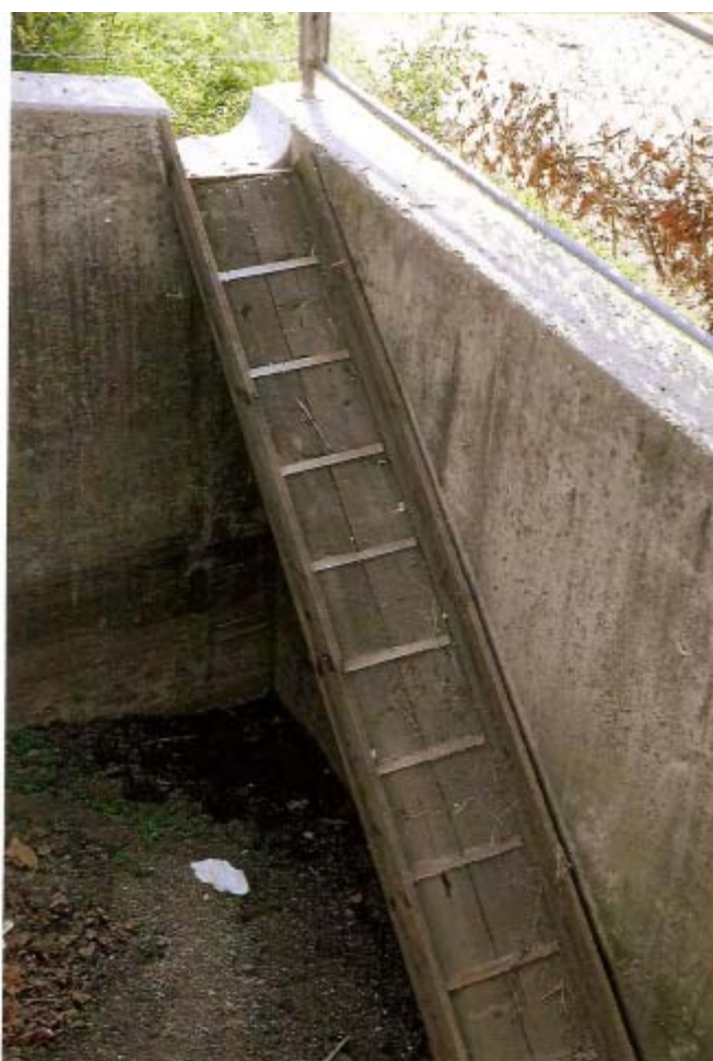
Abb. 6: Schlammfang (5) . Nach dem Um- bzw. Einbau der Ausstiegshilfe. Foto: HANS ECHTER
