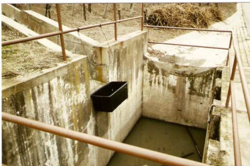
Abb. 1: Amphibienfangvorrichtung in Schlammfang (1) . Mit dieser Methode versuchte Hans Echter in den Jahren 1987 und 1988 ein Hineinfallen von Amphibien in den Schlammfang zu verhindern und gleichzeitig die Anzahl der betroffenen Amphibien zu ermitteln. Foto: HANS ECHTER.
